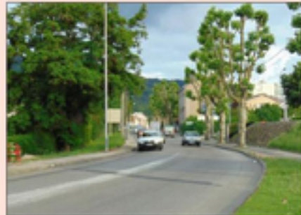
■ Les travaux iront jusqu'à l'entrée du grand rond-point, près du centre commercial. Photo Jean-Marc BERTHOMIER
