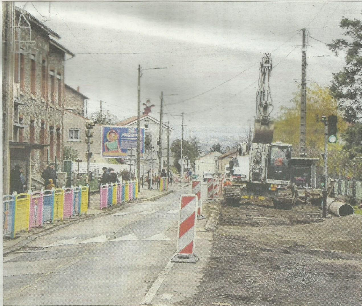
Les travaux commencés cet automne devraient durer jusqu'à l'été 2023. Photo Progrès/Jean-Marc BERTHOMIER
