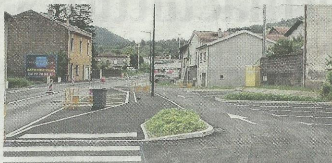
Le parking au-dessus de l'école a été repensé pour créer un arrêt de bus et a été végétalisé. Photo Jean-Marc Berthomier
