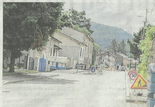
Les travaux de réfection du dernier tronçon du boulevard Fayol (rue des Aubépines - rond-point du Bas de la Côte) vont se terminer dans les prochains jours. Photo Jean-Marc Berthomier
