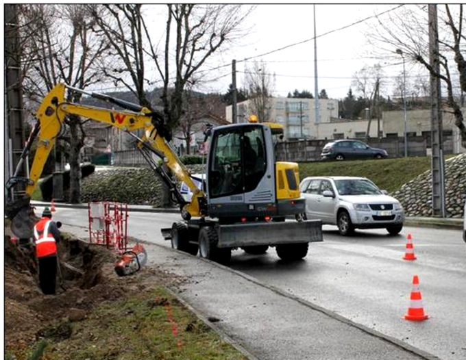
■ Le remplacement d'une ligne à haute tension perturbe la circulation sur le boulevard Fayol. Photo Sacha MARTINEZ
