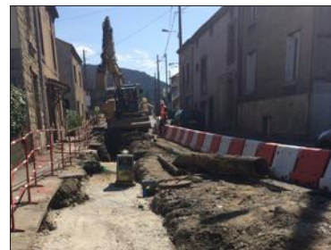
■ La durée des travaux pourrait être revue à la baisse. Photo Christian GIL
