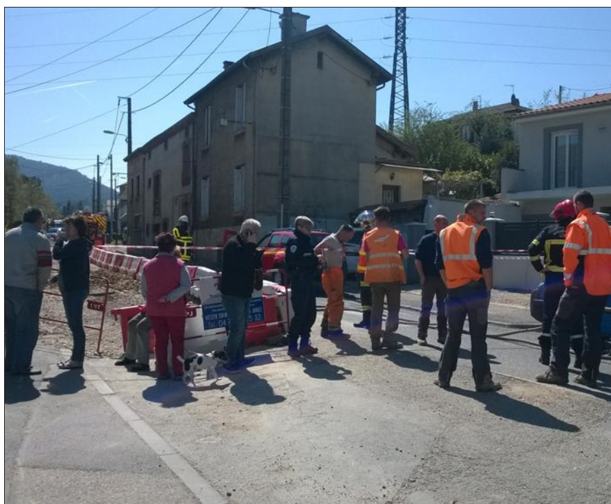
■ La réparation sur le boulevard Fayol a contraint les pouvoirs publics à interdire la circulation sur la RD500 une partie de la journée. Photo Christian GIL
