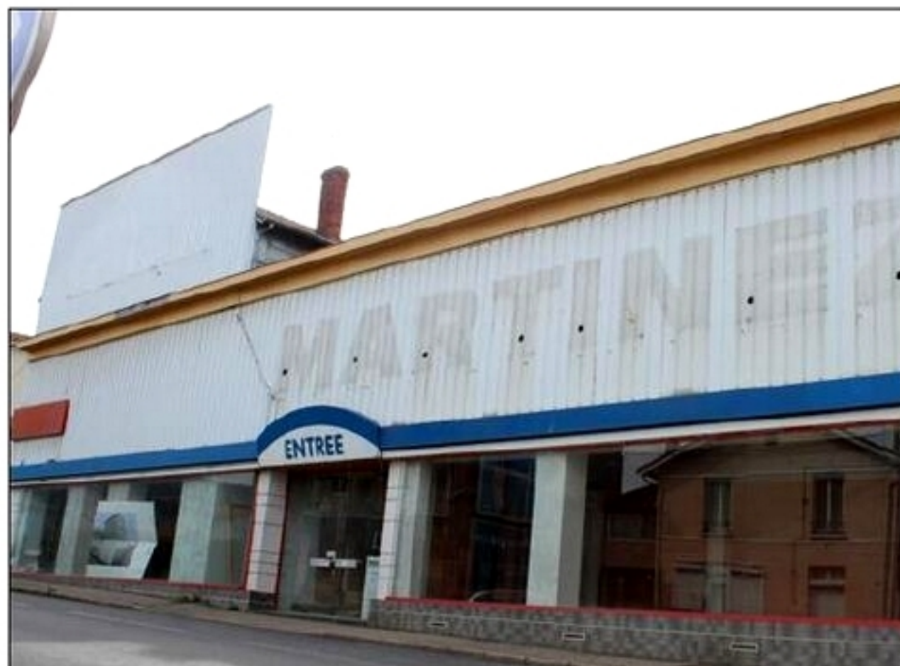
Les anciens locaux Martinez, « une verrue à l'entrée de la ville dont il faut se débarrasser ». Photo Progrès/Jean-Marc BERTHOMIER
