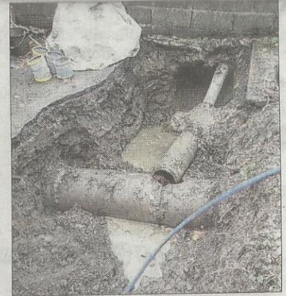
■ La conduite d'eau potable va être remplacée et les branchements d'adduction mis aux normes. Photo Christian GIL
